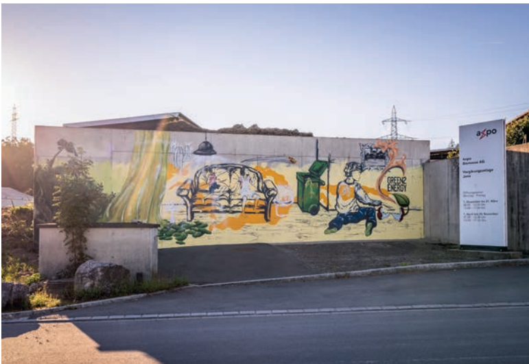
Im Joner Engelhölzli entsteht der Energiepark green2energy.
