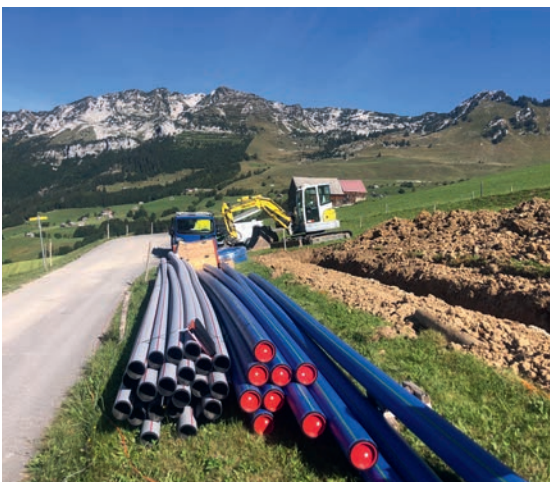
EZL baut die Wasserversorgung in Amden aus.
