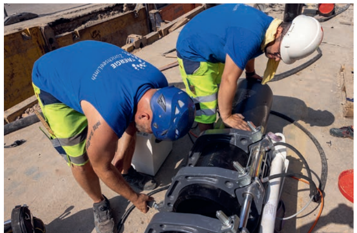
EZL-Fachleute arbeiten am Anergienetz an der Oberwiesstrasse in Jona.
